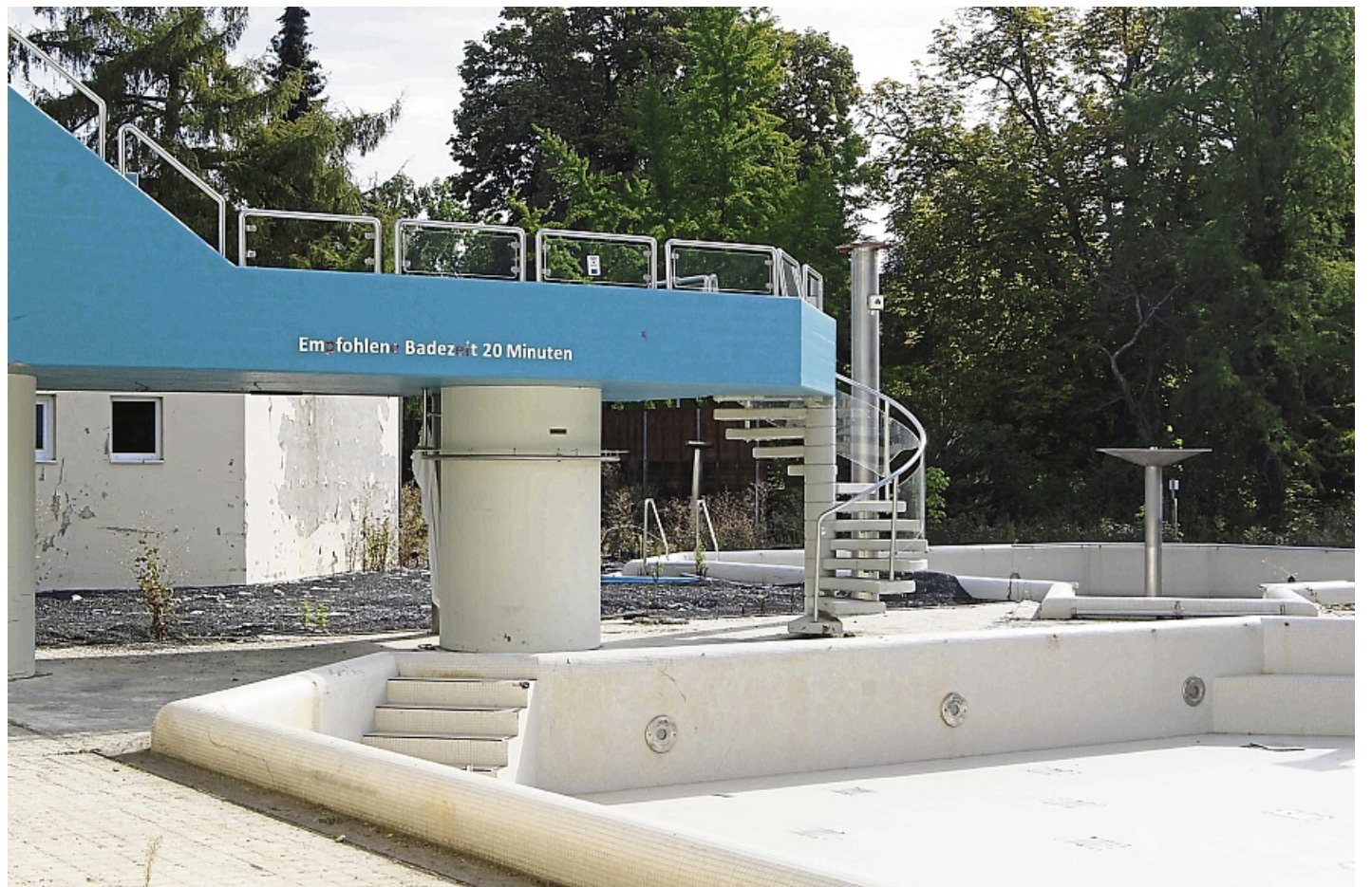
Hier badet schon lange keiner mehr: das Solebecken in der Abbruchruine der Therme in Bad Salzhausen. OLIVER POTENGOWSKI
